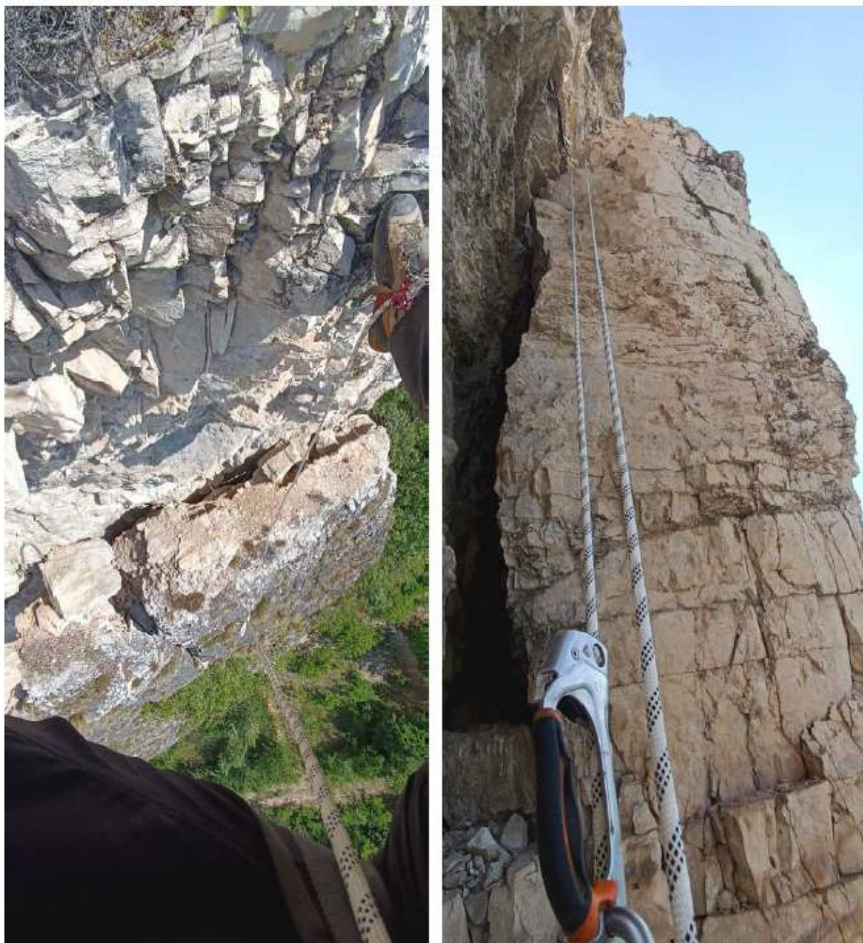
Fig. 3. Foto del diedro instabile scattate dai rocciatori nel corso dell'ispezione visiva di maggio 2026 estratte dalla Relazione di stabilità dei fronti di giugno 2026 (E. Marcato).
